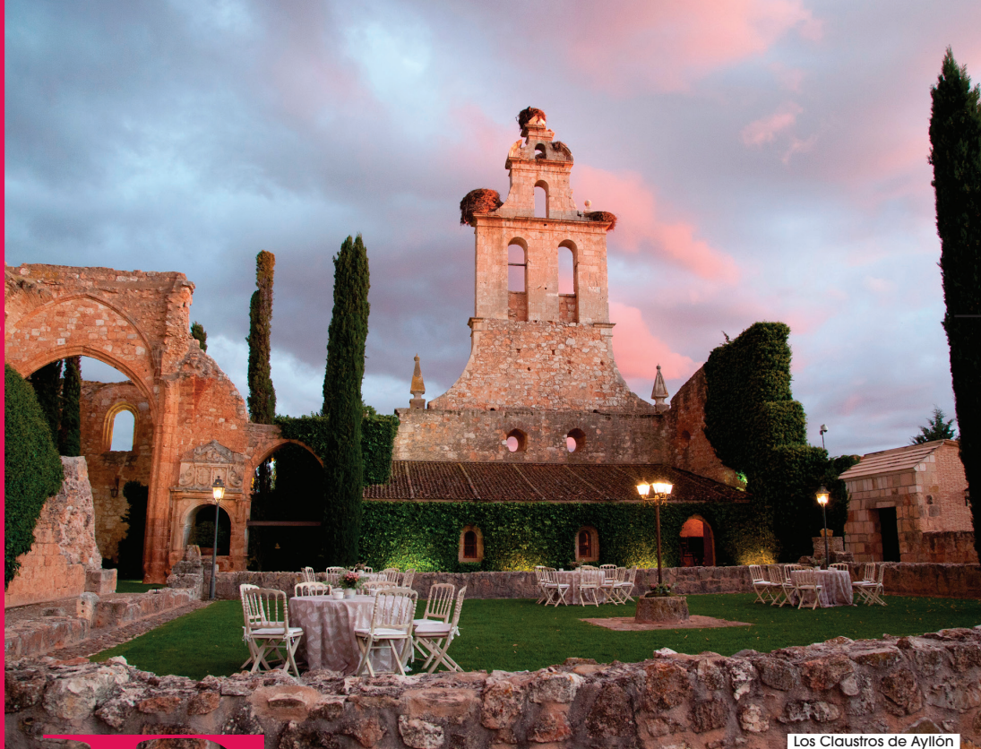
Los Claustros de Ayllón
